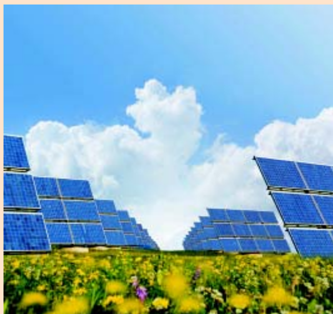
Contoh pemasangan sel suria di ladang
